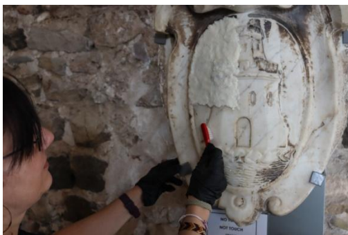
Secuencia de los tratamientos realizados: limpieza química, cepillado, bisturí y repetición de la aplicación de papeta
