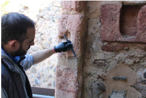
Eliminación de mortero de cemento contemporáneo
