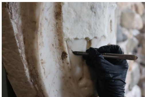
Secuencia de los tratamientos realizados: limpieza química, cepillado, bisturí y repetición de la aplicación de papeta
