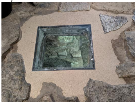
Imágenes de cambio de marco y cristal de la canalización de la calzada
