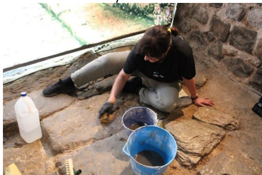
Tratamientos de limpieza mecánica en el enlosado de la calzada.
