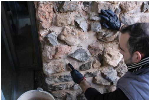
Tratamientos de limpieza mecánica de intersticios
