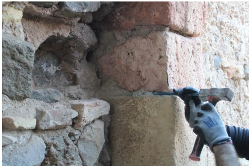
Tratamientos de limpieza mecánica de intersticios
