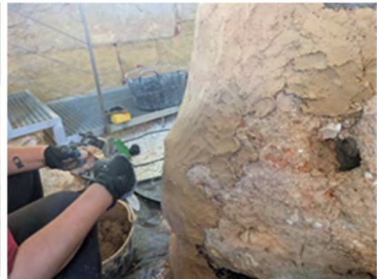
Aplicación de la costra de sacrificio
