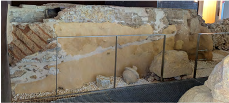
Imagen previa y final de la consolidación de la zona trasera de la escalera.
