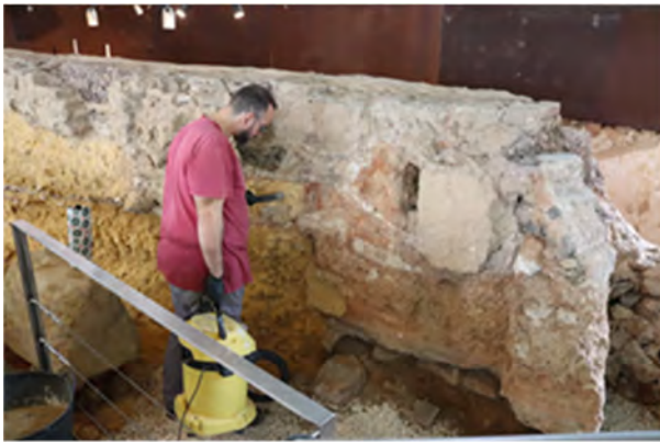
Aspirado y retirada de escombros
