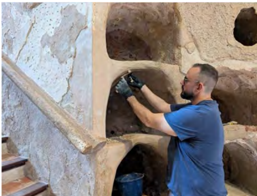
Ejemplo de aplicación de mortero
