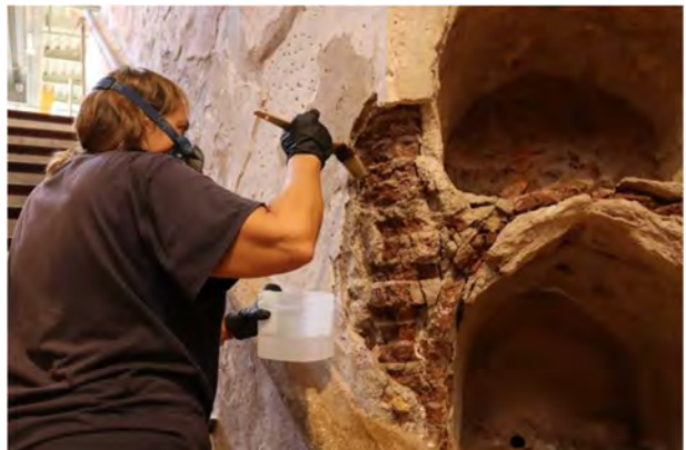
Consolidación mediante impregnación con silicato de etilo.
