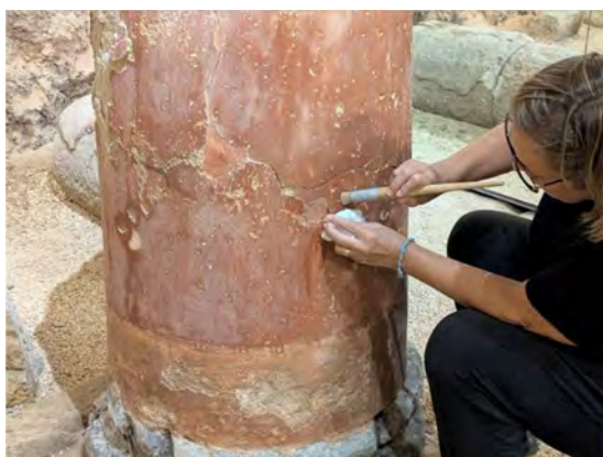
Tratamientos de limpieza en el revestimiento de las columnas
