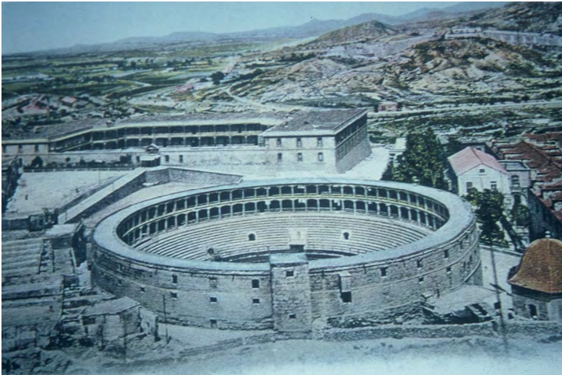
Foto histórica 8 _ Plaza de Toros (proyecto 1854) y Cuartel de Antiguones
