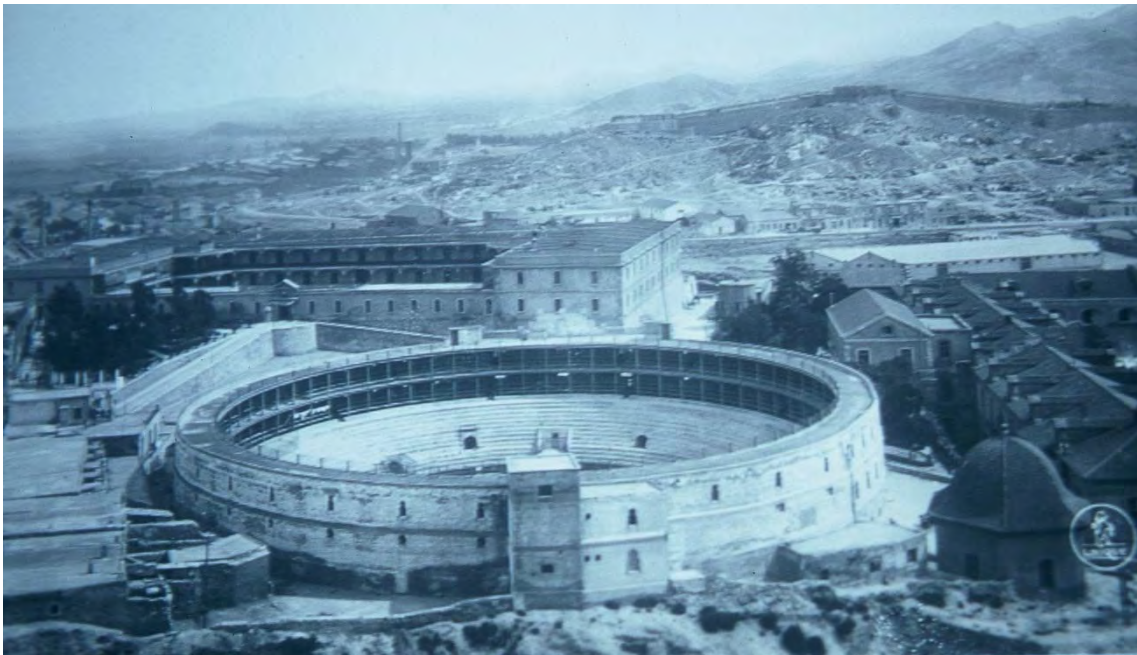
Foto histórica 10 _ Plaza de Toros (proyecto 1911) y Cuartel de Antiguones
