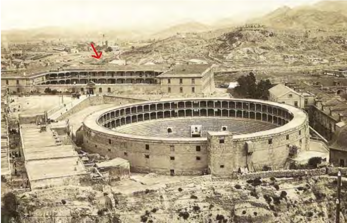
Foto histórica 5 _ Plaza de Toros (proyecto 1854) y Cuartel de Antiguones
