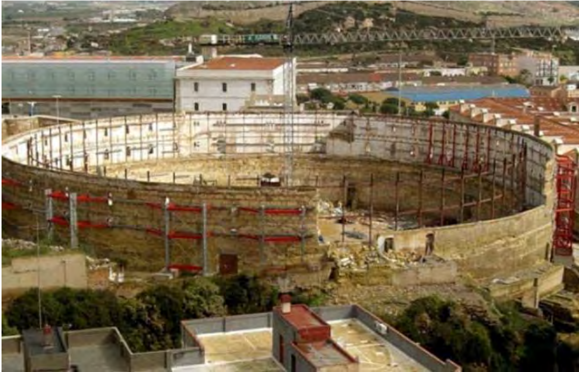
Foto histórica 23_Plaza de Toros, estado actual
