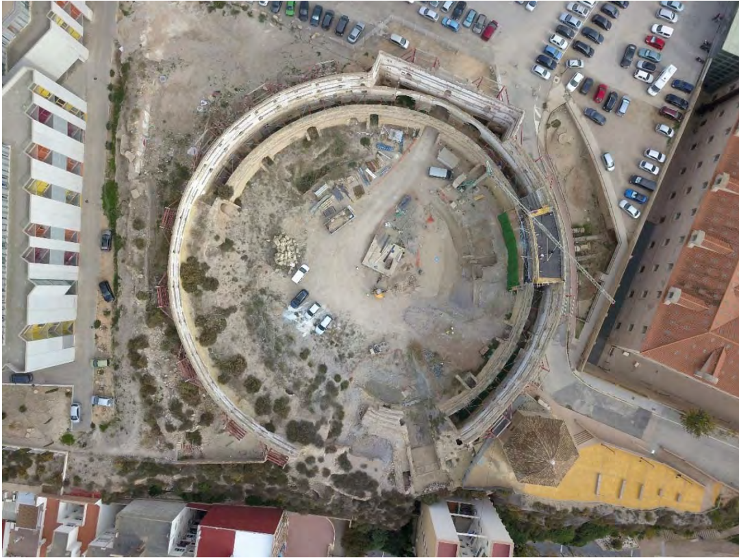
Situación actual (Dic 2018) 18 - Situación obras fase 1
