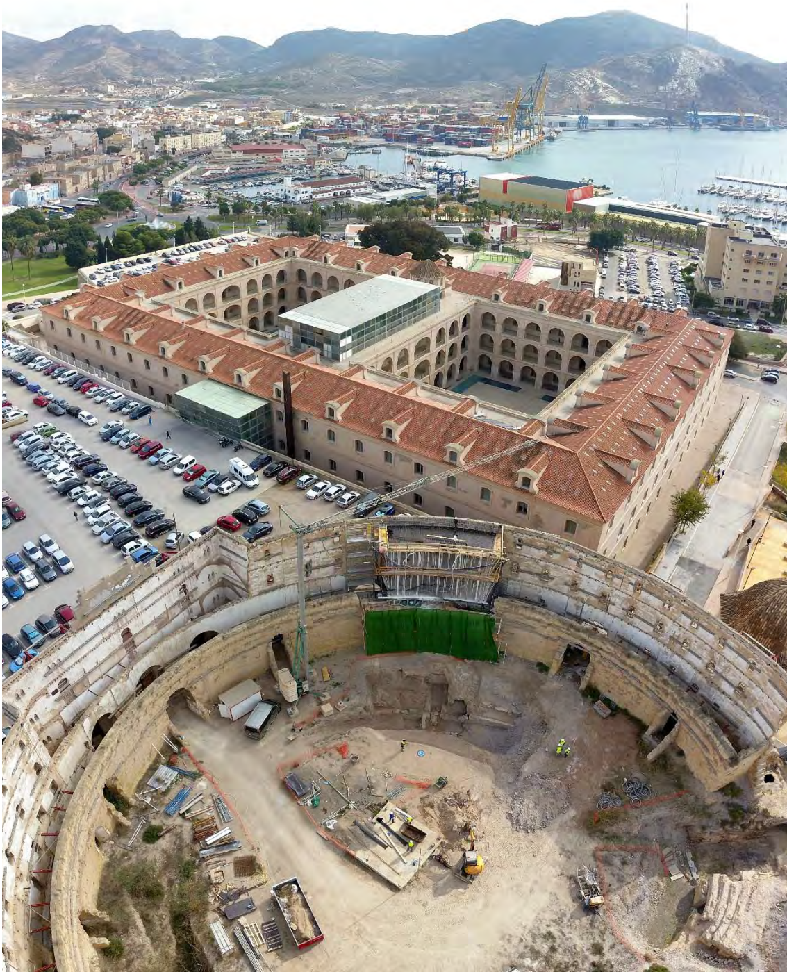
Situación actual (Dic 2018) 17 - Situación obras fase 1
