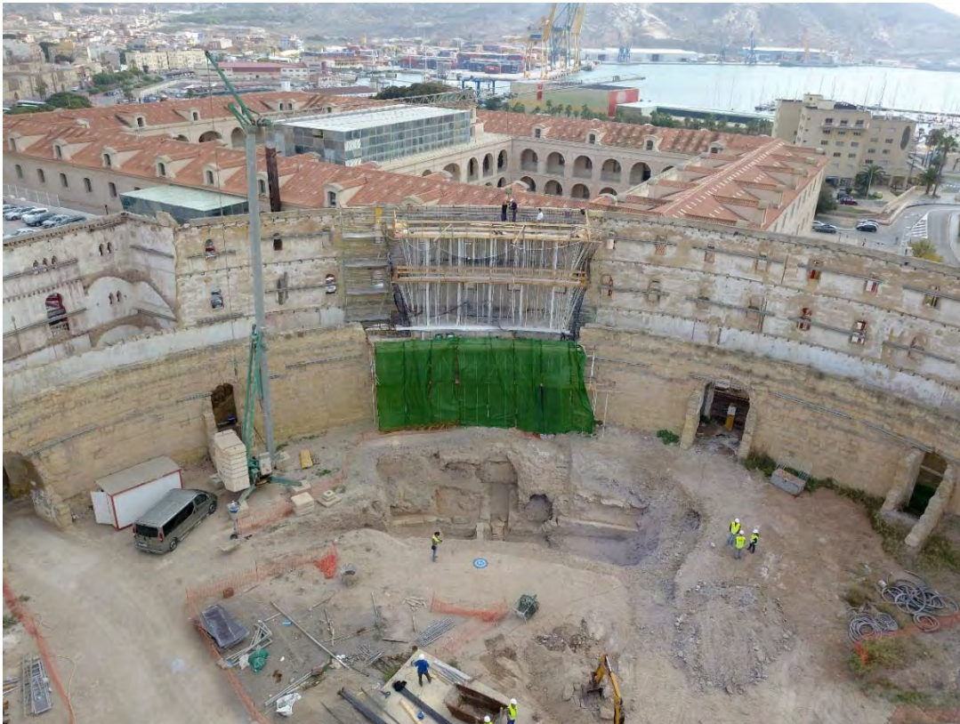
Situación actual (Dic 2018) 19 - Situación obras fase 1
