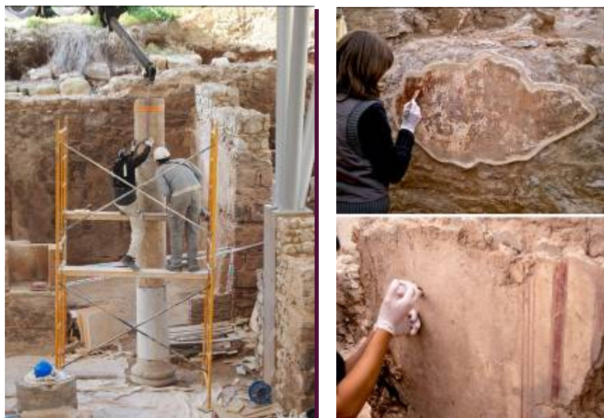
Trabajos de restauración en el Edificio del Atrio. 2012
